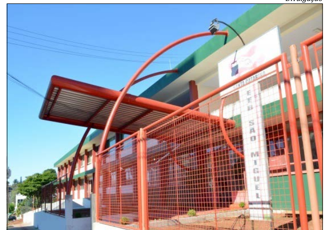
A reforma iniciou ainda em 2013, mas até agora as obras estavam inacabadas
