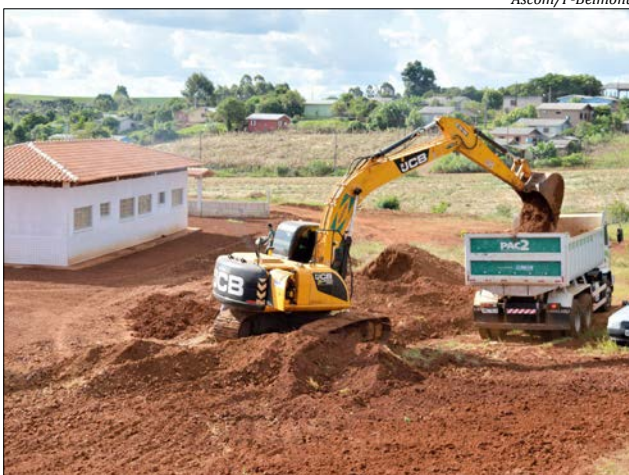
A obra está na reta final, restando apenas o término de alguns serviços para viabilizar o início das aulas no novo espaço
