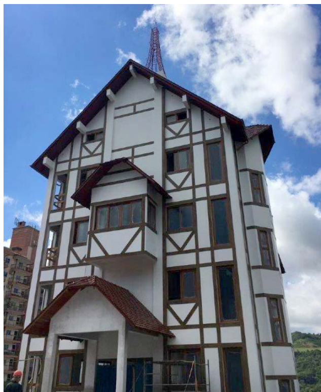
Prédio da Rádio Itapiranga, construído em estilo germânico, está praticamente concluído
