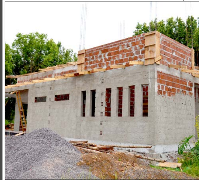
Cerca de 50% de sua obra concluída
