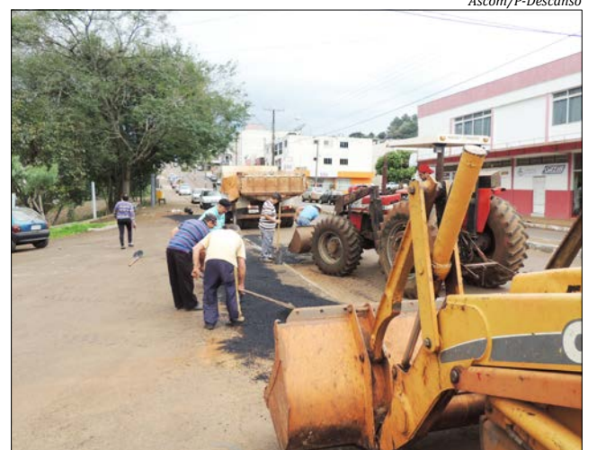
Trabalhos estão sendo desenvolvidos em diversas avenidas e ruas
