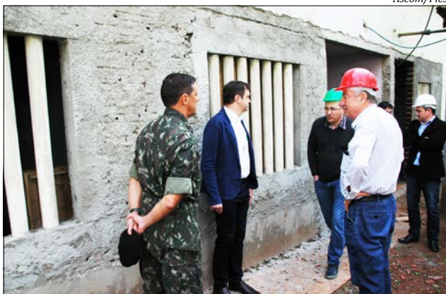
Astor Kist (D) e autoridades do judiciário e das forças de segurança vistoriaram as obras
