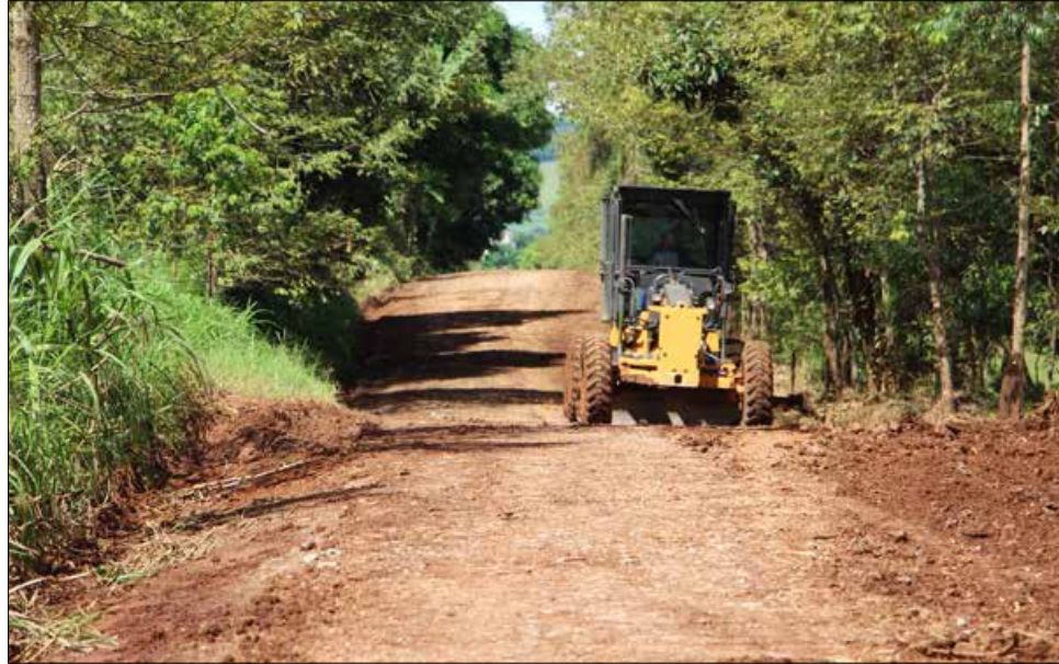
Serviços na estrada Beira Rio iniciaram já na semana passada
