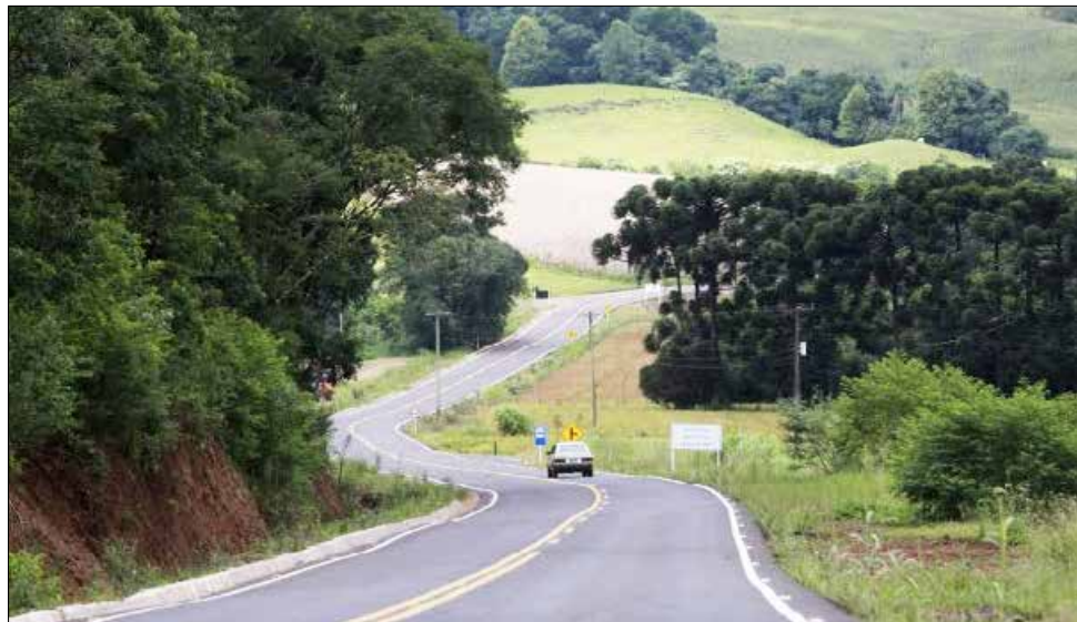
Trecho da obra tem oito quilômetros e vai ligar a BR-163, na Linha Esquina Derrubada, a comunidade de Santo Isidoro
