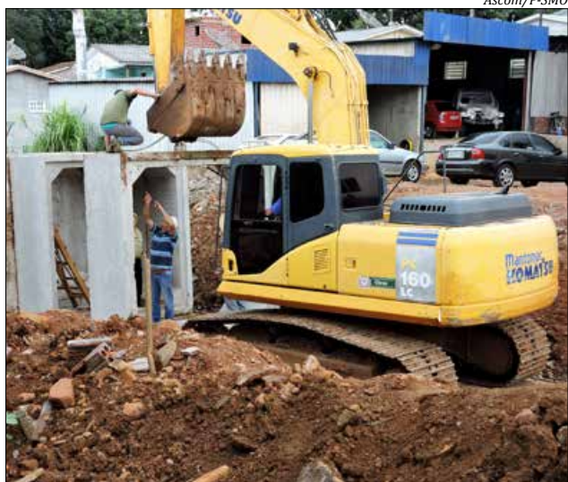
Após a conclusão desta etapa, a Secretaria vai trabalhar na reposição do aterro e colocação da capa asfáltica
