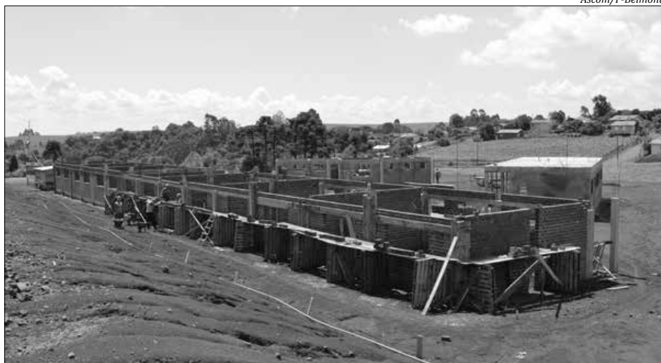
Pelo menos 30% das obras já estão concluídas
