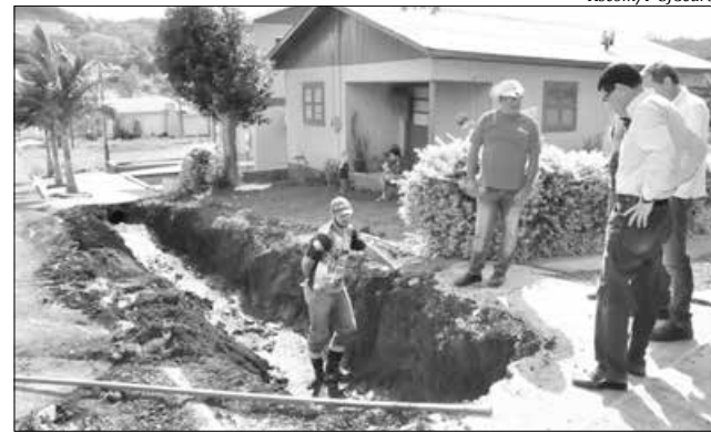
Na Rua Tiradentes, Plínio de Castro acompanhou o serviço de recolocação de tubos
