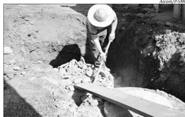
Novas fossas vão resolver os problemas de vazamento existente no Bairro
