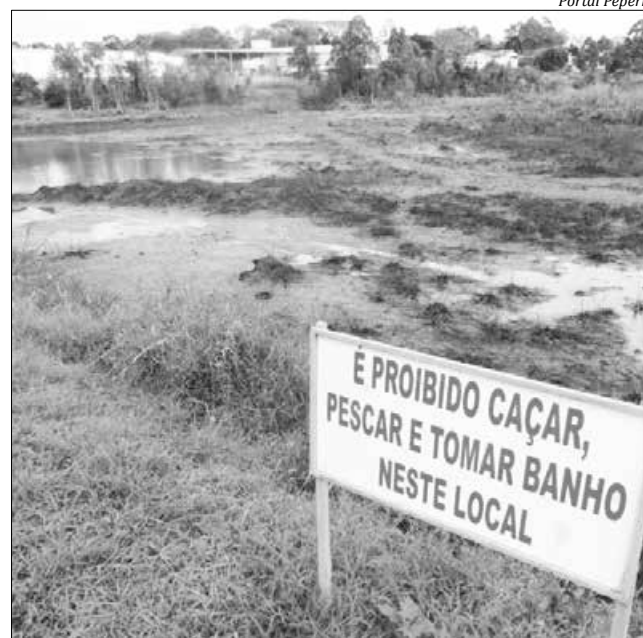
Açude secou totalmente após vaziar milhões de litros de água
