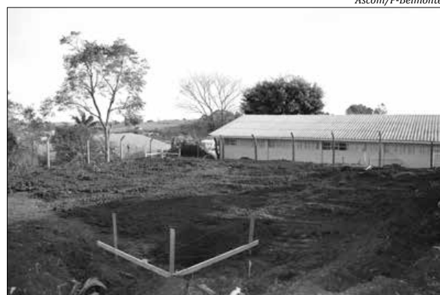
Local está sendo preparado para receber o novo parquinho
