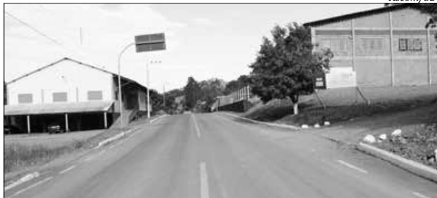
Na obra asfáltica de 3.855 metros quadrados foi investido R$ 303.610,59
