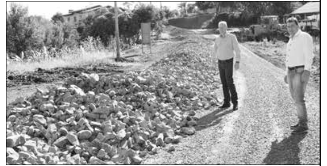
Secretário regional, Wilson Trevisan (E) e o prefeito Roque Meneghini vistoriaram as obras ligando a área urbana de Guaraciaba à comunidade de Linha Índio
