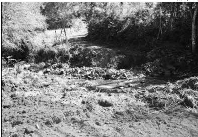
A nova ponte será construída na Linha Müller, sobre o Rio Tabajara, destaca.
