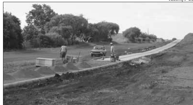
A primeira etapa possui 1.539,50 metros quadrados, um investimento de R$ 135.047,91
