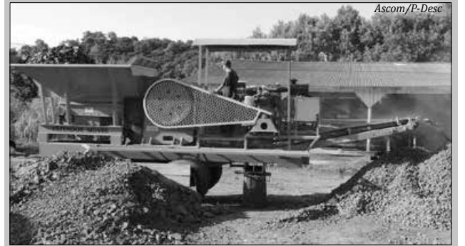
Equipamento já começou a produzir brita para uso em calçamento
