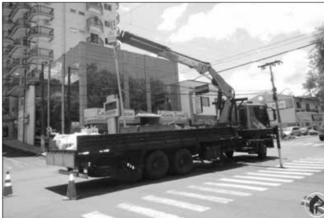
Empresa responsável começou a instalação dos equipamentos
