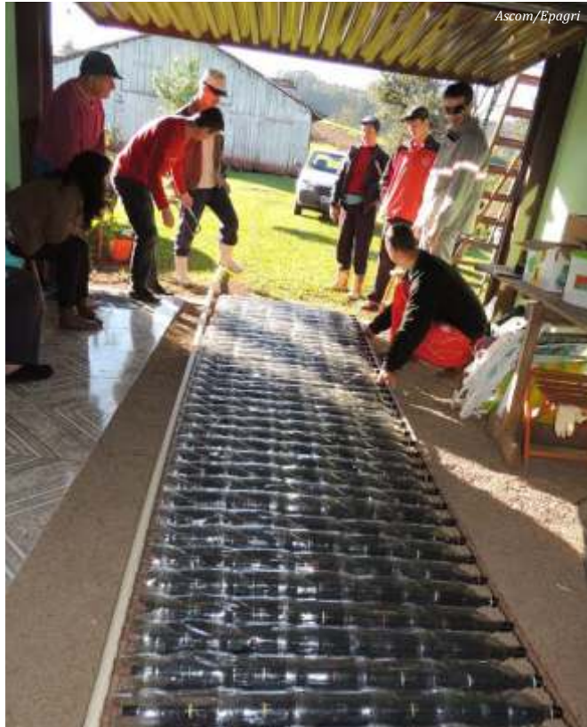
Aquecedor solar foi montado na propriedade em Linha Pitangueira
