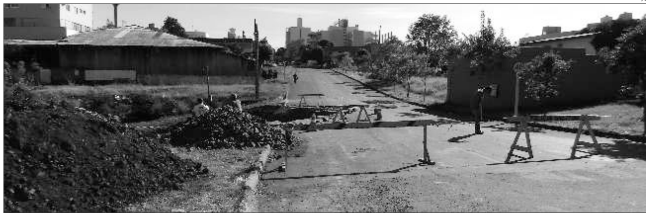
A rua está interditada para segurança nos trabalhos e dos usuários
