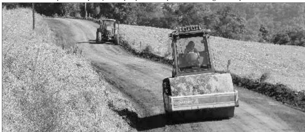
Estradas do interior recebem atenção para facilitar acesso ao município
