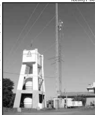
Na última quarta-feira foi instalada a última torre com a antena de captação e distribuição do sinal
