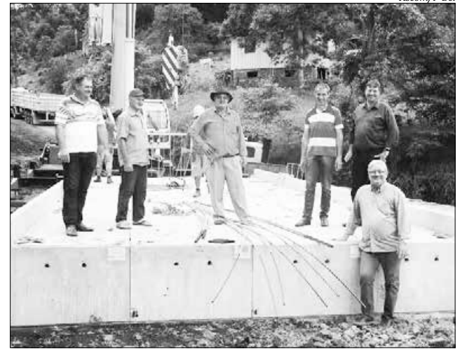
Estrutura pré-moldada foi instalada sexta-feira
