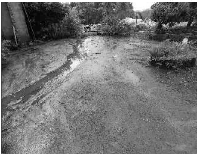
Água da chuva acabou esparramando o piche, que desceu pela encosta
