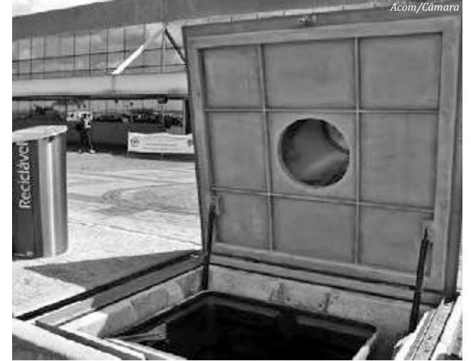
No modelo sugerido, contêineres ficam no subsolo da calçada
