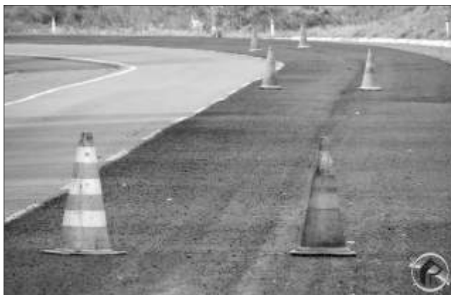
Tráfego é feito em meia pista nos trechos em obras
