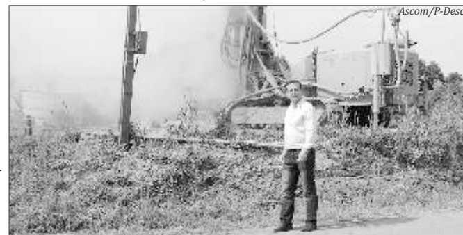
Prefeito Hélio Daltoé visitou o local onde a torre está sendo instalada
