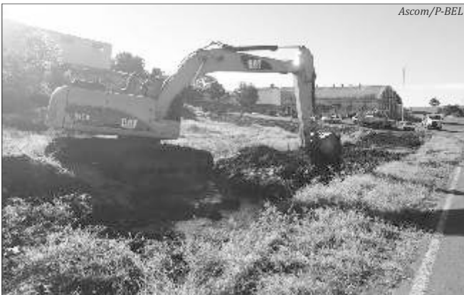
Máquinas trabalham na remoção de terra para início das obras
