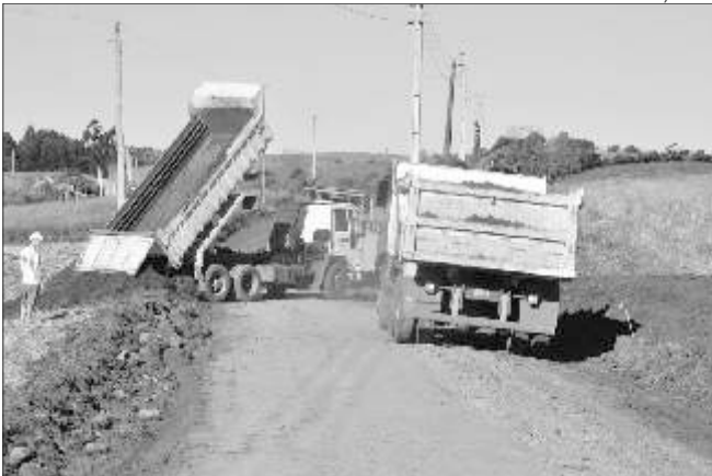
Caminhões e máquinas trabalham intensamente na obra
