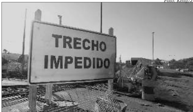
Bloqueio foi feito para construção do viaduto
