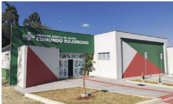
Novo endereço da unidade: Rua Hélio dos Anjos Ortiz, nº 1201, Bairro São Jorge
